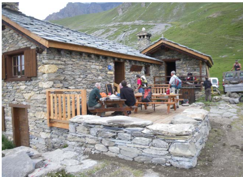
aménagement de l'entrée du refuge de Vallonbrun (2009)
