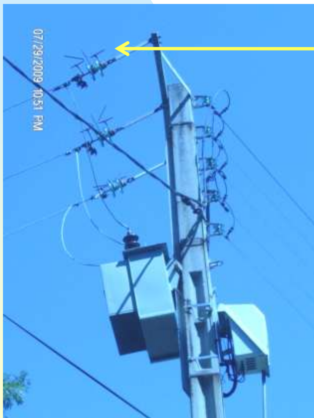
Eclateurs à cornes d'accrochage d'arc
